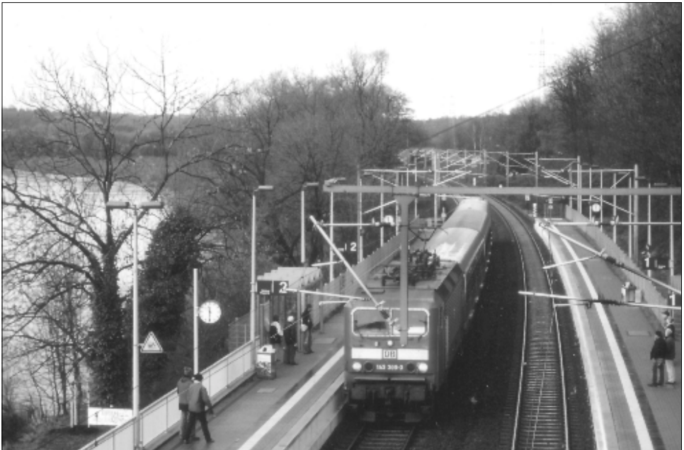
Ein Wendezug der S 9 hält am neuen Bahnsteig in Essen-Holthausen. (Foto: Bernhard Quack)
