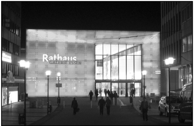
Die Fassade der Rathaus-Galerie leuchtet nachts in bunten Farben. Jedoch weist nichts darauf hin, dass sich hier Essens zentrale Straßenbahnhaltestelle verbirgt. Foto: Oliver Stieglitz
