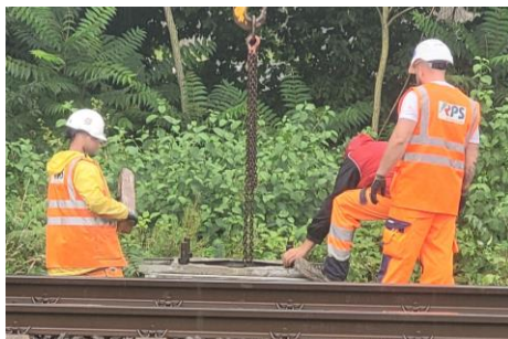
Arbeiten an einem Fundaments für einen Strommast der S28 © privat
