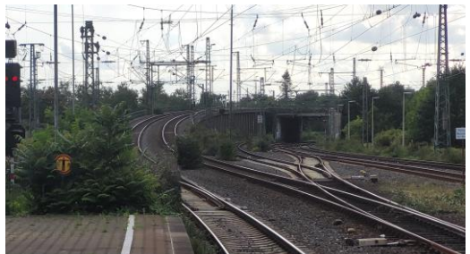
Ein Überwerfungsbauwerk, Beispiel für eine KMM, ermöglicht mehreren Zügen gleichzeitiges Fahren. © privat
